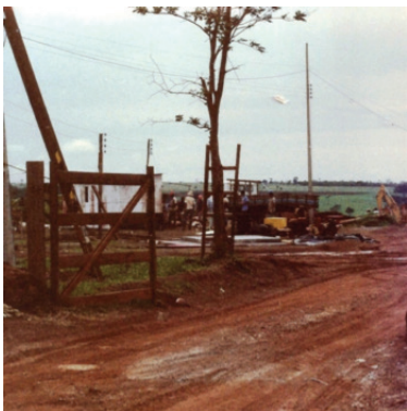
Figura 1: Entrada do depósito provisório em construção Fonte: Telma Camargo da Silva (Foto: 1987)
