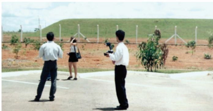
Figura 13: Depósito permanente de rejeitos. Na imagem, um dos “morros” no interior do qual foi construído o prédio contendo os rejeitos radioativos
